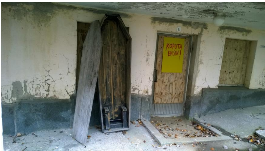
Kuva 2. Rakennuksen pohjoispäädyn graniittisokkeli.
