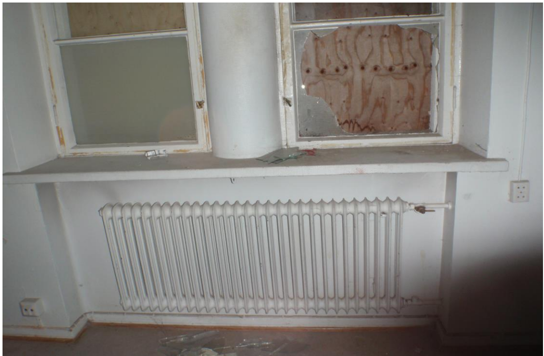
Kuva 31. Valurautainen patteri ja vanha patteriventtiili
