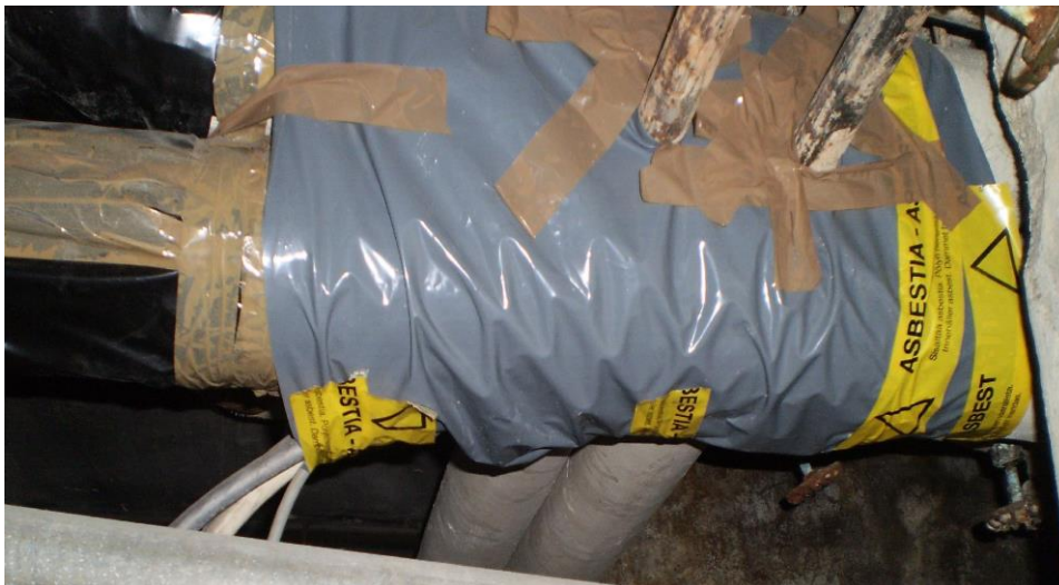
Kuva 33. Lämpöjohdot kanaalissa.
