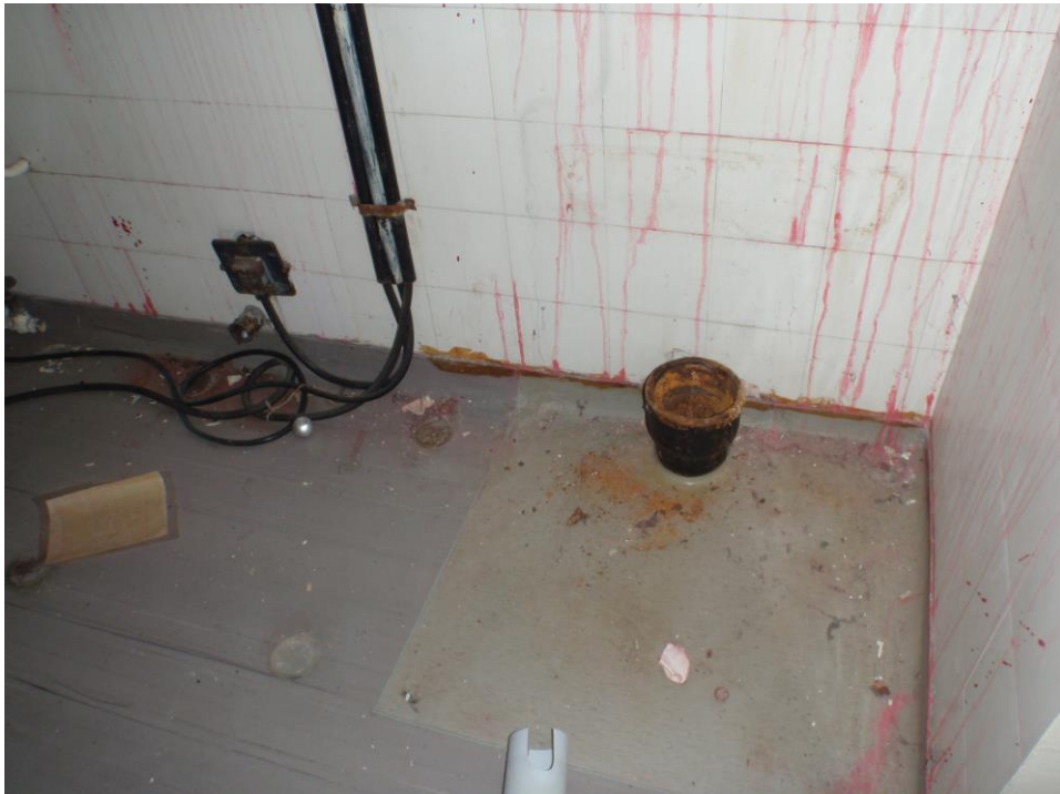
Kuva 24. Vanhan keittiön viemäriputki.
